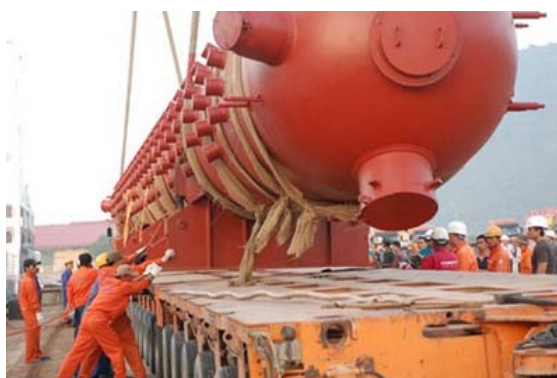
Vận chuyển bao hơi vào vị trí lắp đặt
